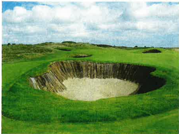
12番フェアウェイ中央のバンカー。バンカーの壁は皆枕木で補強されている
